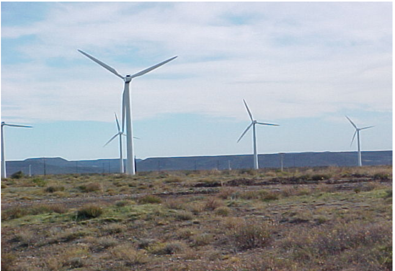
Parque Eólico Pico Truncado Provincia de Santa Cruz -Argentina
